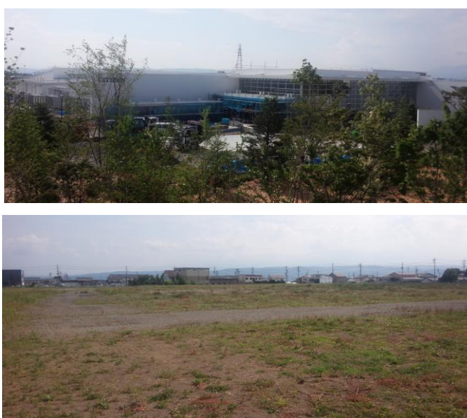
上：建設が進むシチズン時計工場 下：東芝電池跡地
