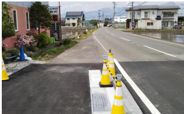
JA高瀬集荷場から横和交差点に向けて歩道の整備が進んでいます
