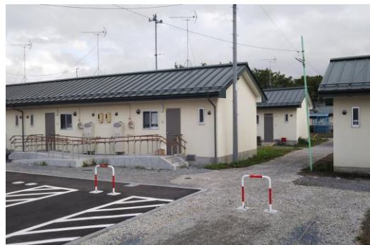
リフォームが完了した市営住宅 一方、県営住宅は手つかずのままです
